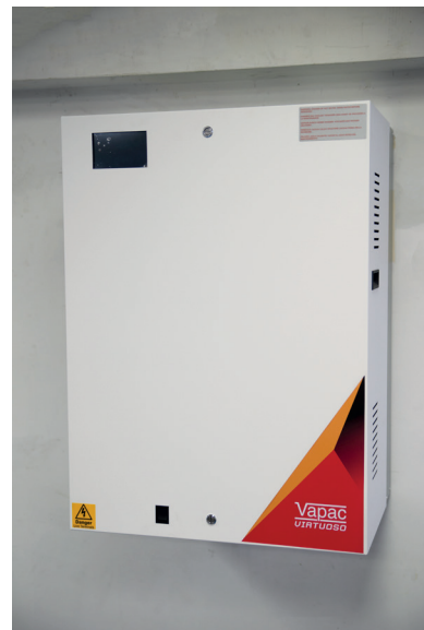
Fig 2j - Luchtbevochtiger gemonteerd met frontpaneel op zijn plaats vergrendeld
