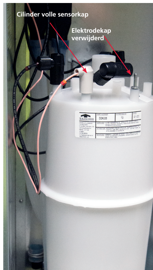
Fig 15 - stoomcilinder met elektrodekappen
