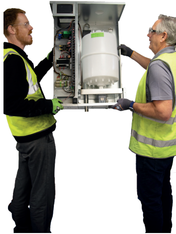
Fig 2d - Het apparaat op het tabblad hangen, wordt op de beugel geplaatst
