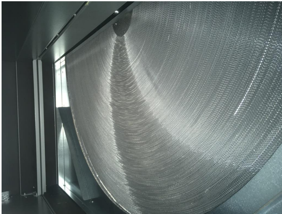
Figure 5 : Vue de l'échangeur thermique du système
