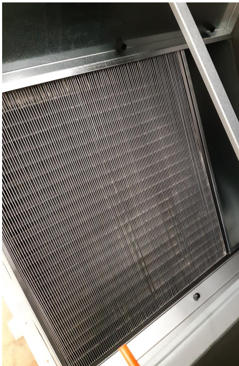
Visuel de la section d'entrée de l'échangeur de chaleur
